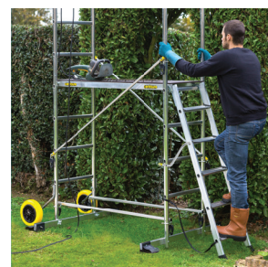
/// Accès sécurisé et confortable par une échelle à marches.
